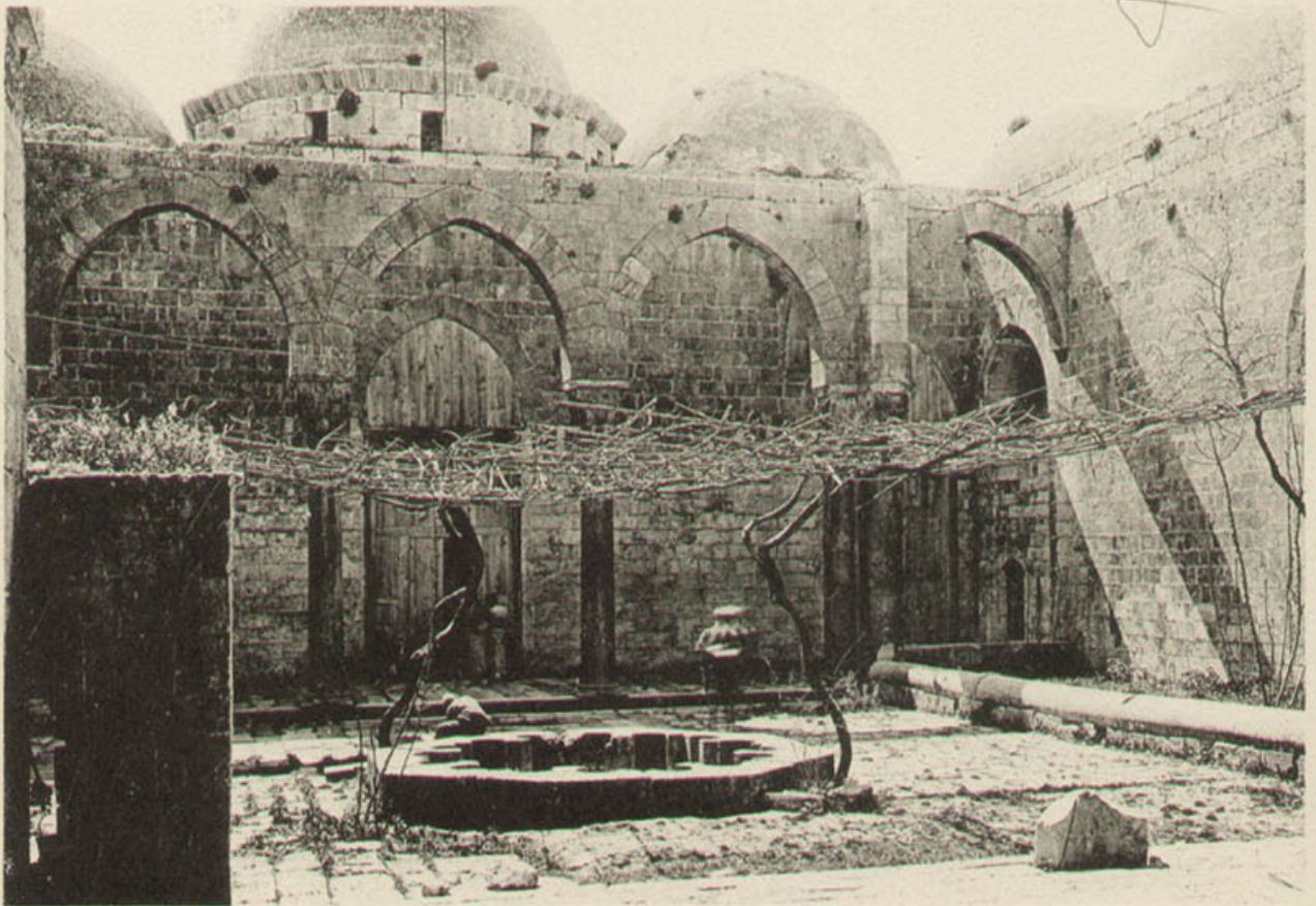
b. Idem , façade Sud, avec qibliyya.
