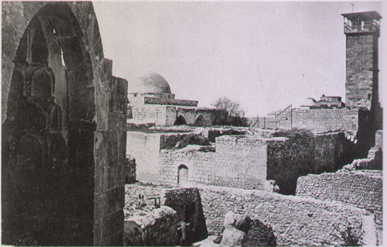
a. Maqâmât, mausolée de Qarasonqor; vue depuis la porte de la Kâmilîyya.
