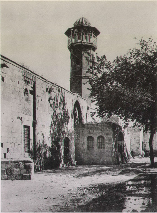
a. Djami' al-Tawashi, vue générale.
